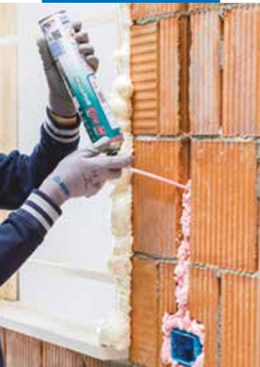
Llenar una pista eléctrica
